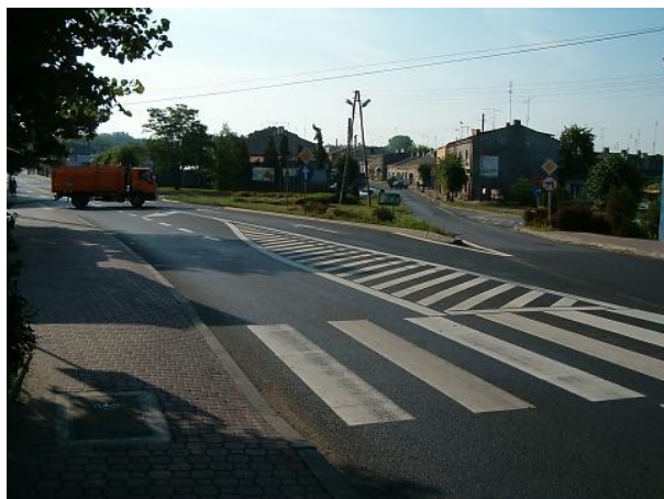
Skrzyżowanie dróg krajowych w Sulejowie
