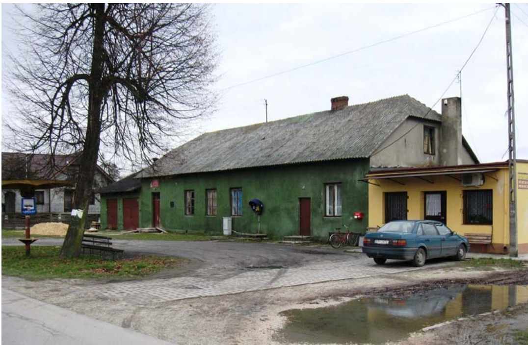
Budynek Ochotniczej Straży Pożarnej w Białej
