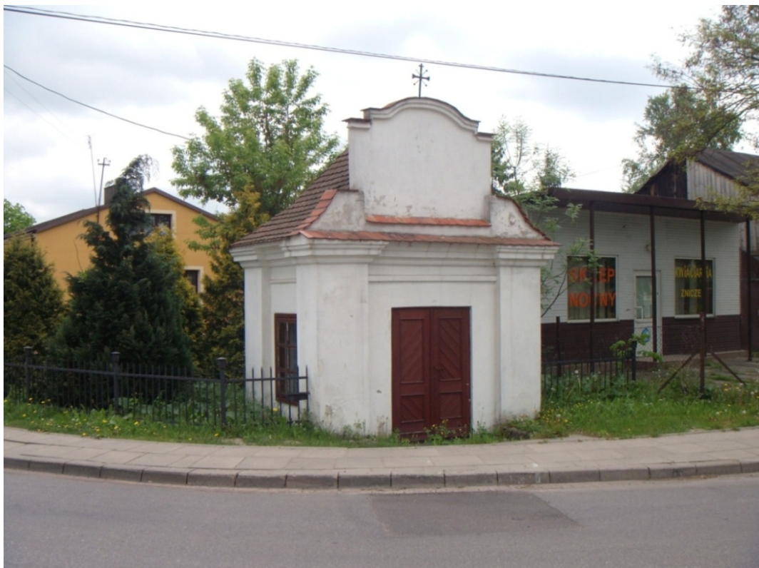
Kapliczka w Sulejowie-Podklasztorzu przed remontem
