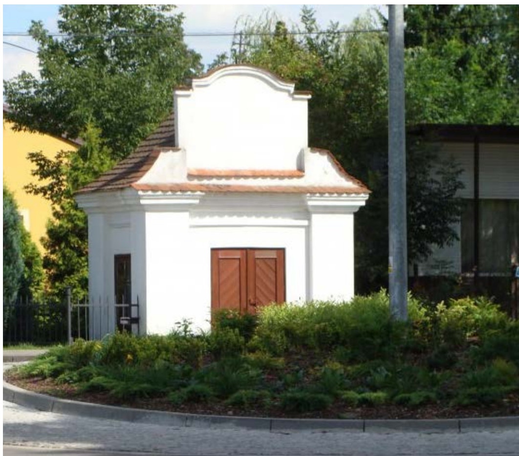
Kapliczka w Sulejowie-Podklasztorzu po remoncie
