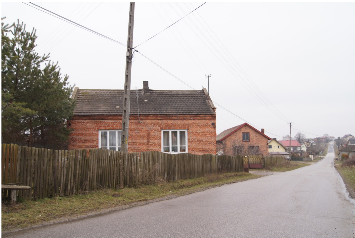
Barkowice układ ruralistyczny wymagający rewitalizacji
