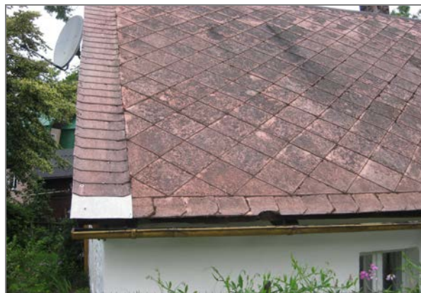
Fot. 2 Płyty azbestowo-cementowe płaskie
