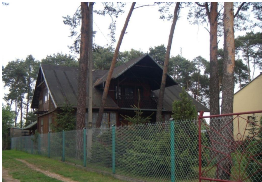
Zabudowa układu przestrzennego w Przyglowie
